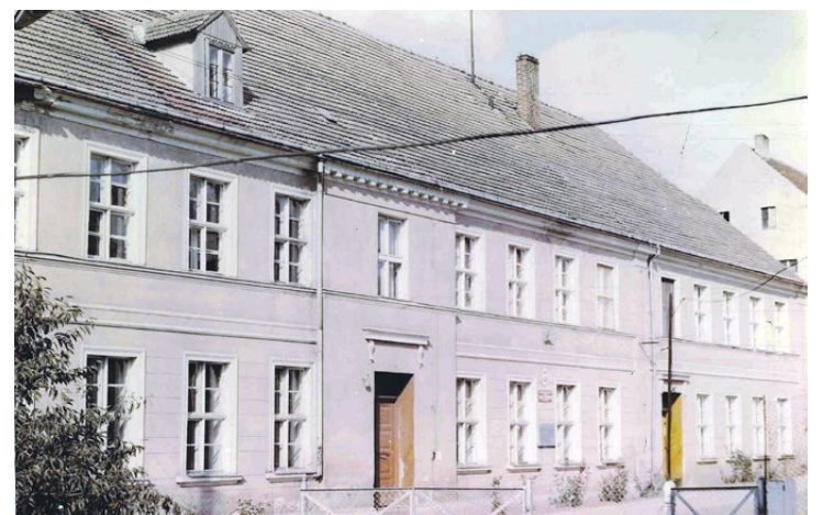
nieistniejący już budynek szkolny przy ul. Chopina
