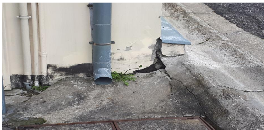
Rysunek 29 Wody opadowe odprowadzane wprost na fundamenty budynków w przestrzeni rynku w Cedyni
