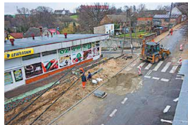
■ Przebudowa dróg i chodników w centrum Cedyni
