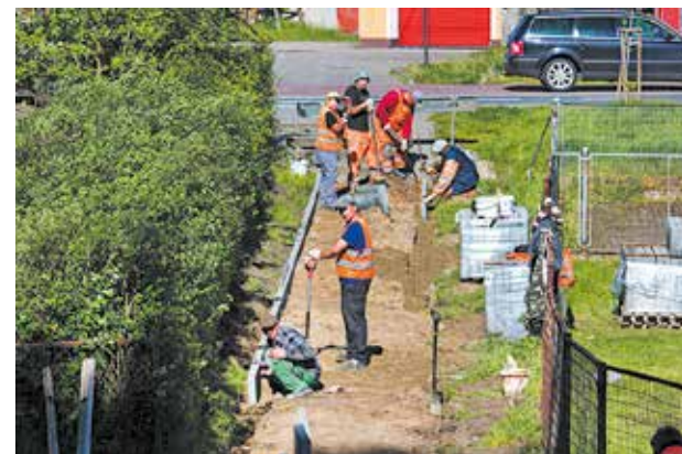
■ Przebudowa chodnika łączącego ulicę Pułaskiego i ulicę Obrońców Stalingradu.
