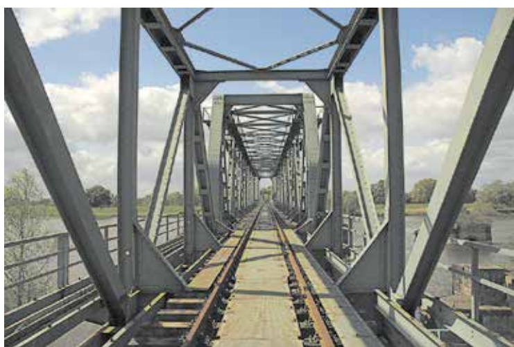
■ Widok na zamknięty most nad Odrą, 2015 rok, fot. P. Pawłowski
